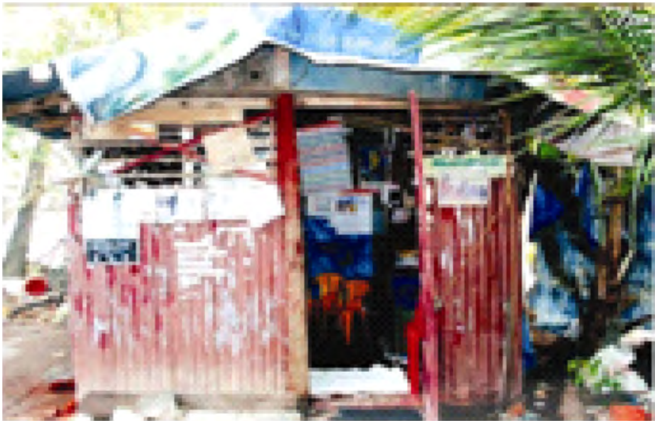
കൊച്ചി നഗരസഭയിലെ അപകടാവസ്ഥയിലുള്ള അങ്കണവാടികൾ
