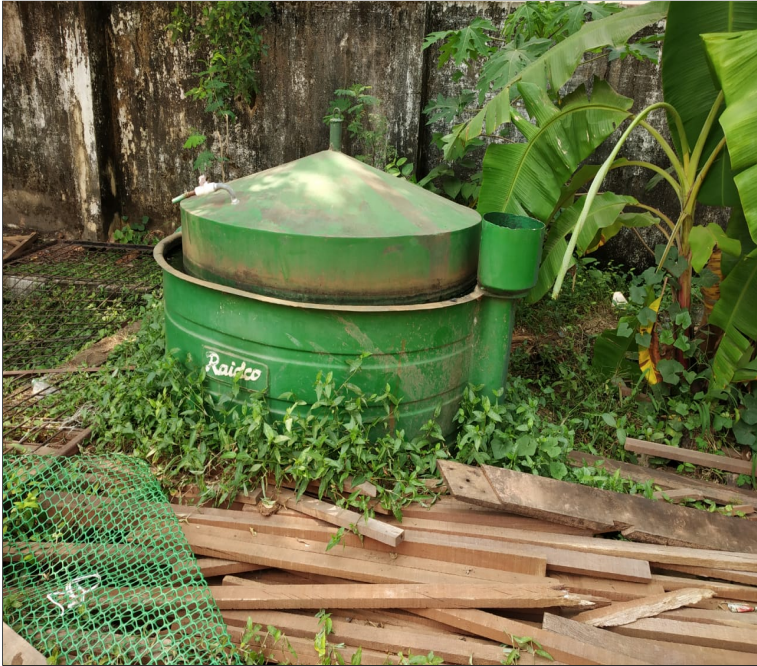
d) സി.എം.സി ബോയ്സ് ഹൈസ്കൂൾ, ഏലത്തൂർ : മേൽ സ്കൂളിൽ ബയോഗ്യാസ് പ്ലാന്റ് ഉപയോഗിക്കാതെ മഴവെള്ളം നിറഞ്ഞ് കിടക്കുകയാണ്. പ്ലാന്റിൽ നിന്ന്
