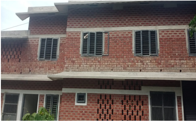
ടേക്ക് എ ബ്രേക്ക് കെട്ടിടം
