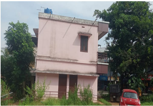
ടേക്ക് എ ബ്രേക്ക് കെട്ടിടം
